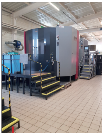
Deux nouveaux centres d'usinage ont été installés pour renforcer les capacités de fabrication des plaques.
