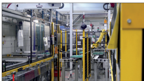
Le site de Douvrain est également doté de moyens d'assemblage automatisés.
