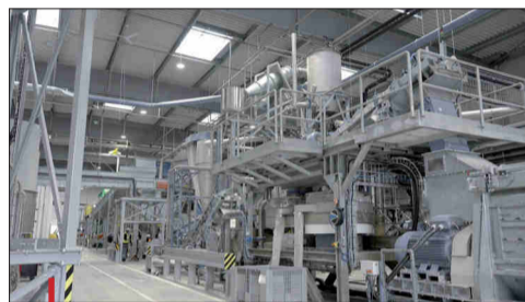
De grande longueur, les deux nouvelles lignes sont installées parallèlement.
