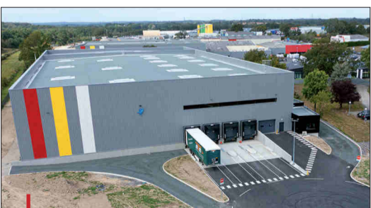
Sur son site de Châteaubriant, RBL dispose désormais de 15 000 m 2 de bâtiments.
