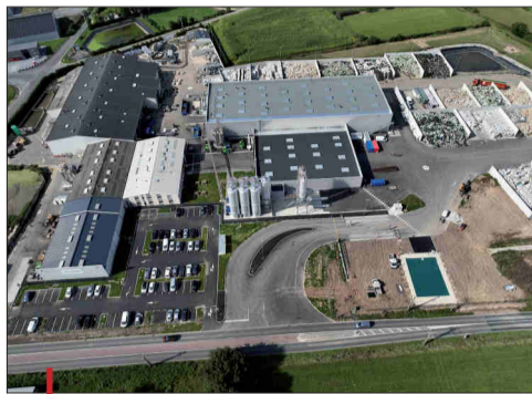
Le site de Landemont dispose de 5 000 m 2 de bâtiments sur 7 ha de terrain.
